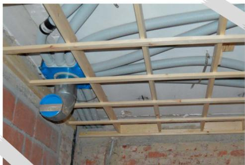
Ine et Louis avaient le désir de cacher des vannes dans les armoires de cuisine à certains endroits. Le manchon d'extension bleu avec capuchon d'étanchéité est présent à l'endroit où la vanne sera placée lors de la finition. La fonction de ce bouchon est d'éviter de la poussière ou de la saleté dans les canaux ou les diviseurs lors de la rénovation.
