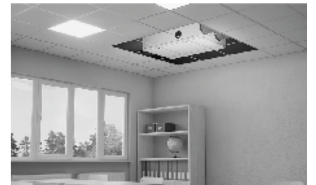
Komfovent Domekt R 700 F weggewerkt in het vals plafond Komfovent Domekt R 700 F dissimulé dans le faux plafond
